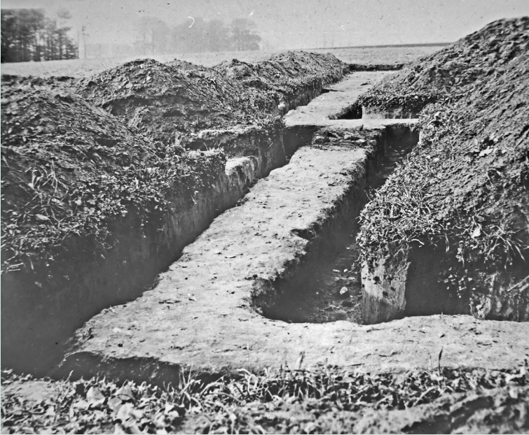
Die 1949 freigelegten Fundamente des südöstlichen Chores und Schiffes der Kirche (Foto: Heimatverein Dornberg)
